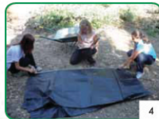
Medir el terreno y cortar el geotextil a medida.
